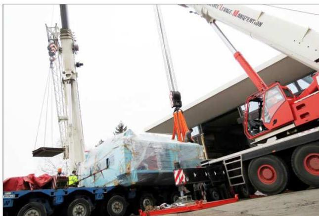
■ Deux grues sont nécessaires pour lever la machine qui voisine les 100 kilos.
